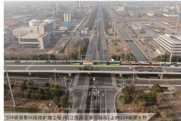
504省道泰兴段改扩建工程(阳江西路至泰常路段)上跨334省道大桥
