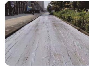
土工布覆盖养护
