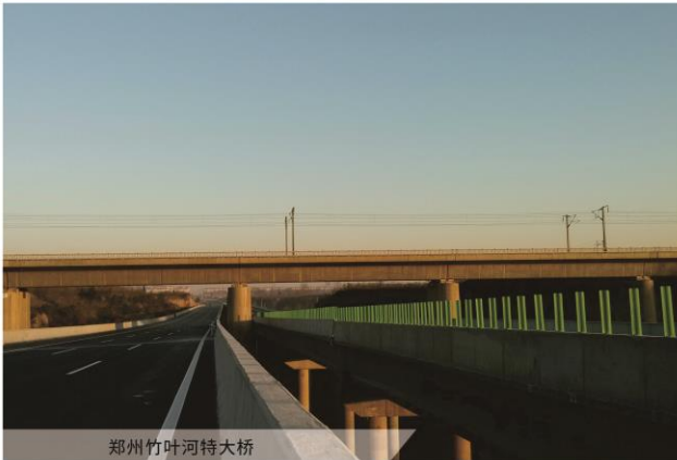
郑州竹叶河特大桥
