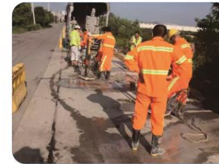
水泥砼路面压浆处理基层坑洞
