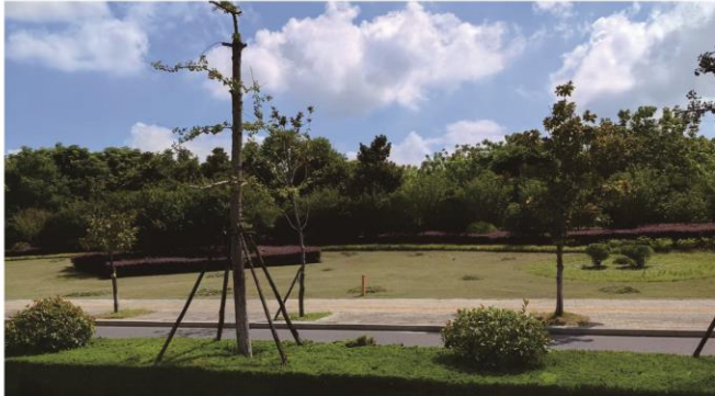
道路两侧绿化工程
