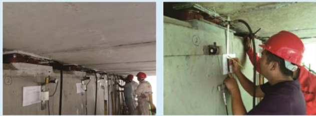
更换支座的PLC控制整体同步顶升系统
