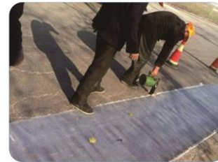
白改黑防裂贴处理老水泥砼路面裂缝
