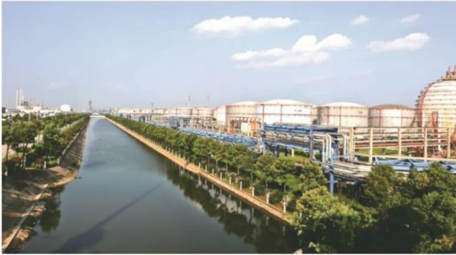
河道整治及绿化工程
